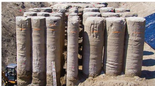
Rys. 1. Przystony wykonane w technologii DSM [1]
