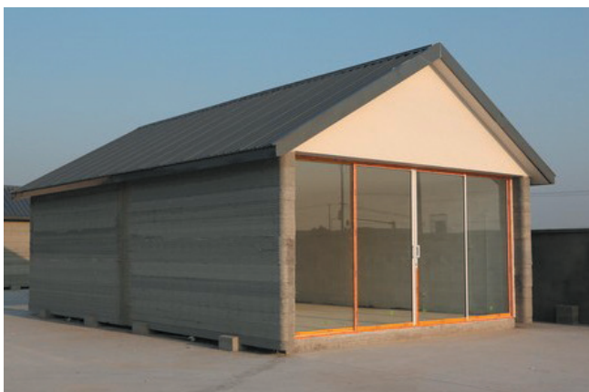
Rys. 3. Parterowy budynek wykonany przez firmę WinSun w technologii druku 3D [20]
