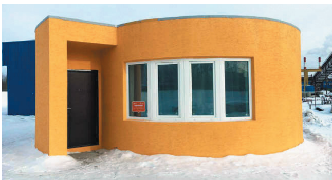
Rys. 5. Dom wykonany według projektu firmy Apis Cor w technologii druku 3D [13]
