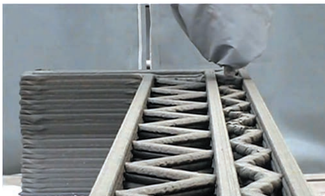
Rys. 2. Ściany tworzone w technologii Contour Crafting [14]
