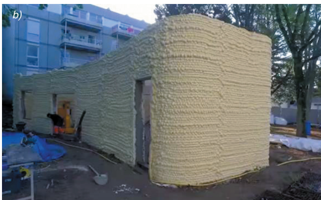
Rys. 6. Dom wykonany według projektu naukowców z Uniwersytetu w Nantes w technologii druku 3D: a) gotowy budynek, b) szkielet ścian [22]
