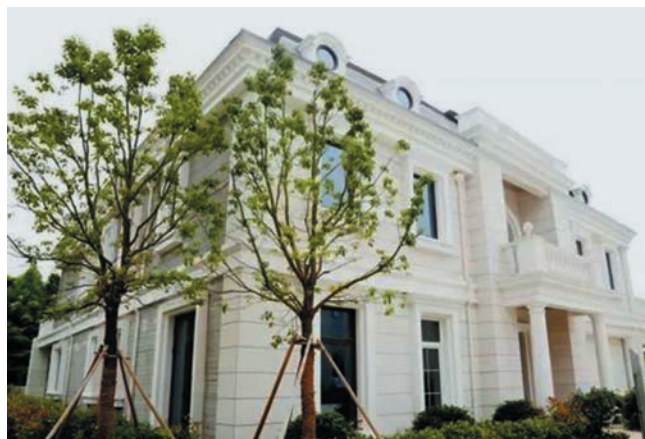
Rys. 4. Wielokondygnacyjne budynki wykonane przez firmę WinSun w technologii druku 3D [21]
